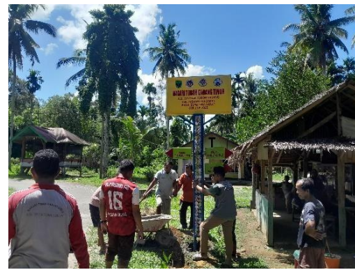
Lampiran X. Proses Pengecoran Plang Penunjuk Arah
