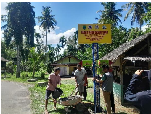
Lampiran IX. Proses Pembuatan Semen Untuk Pengecoran Plang Penunjuk Arah
